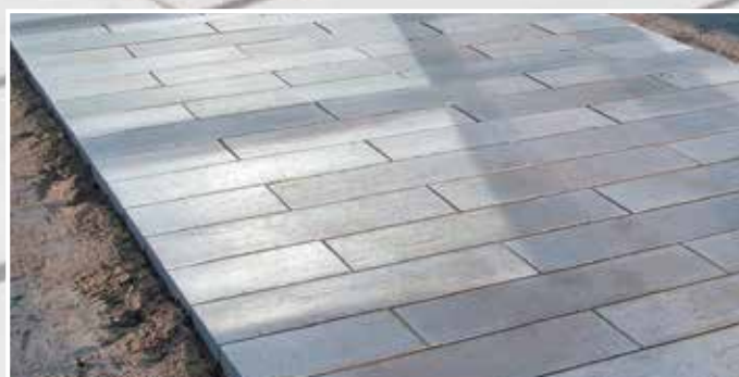
Nawierzchnia ułożona wg wzoru/metody na tzw. miankę.
